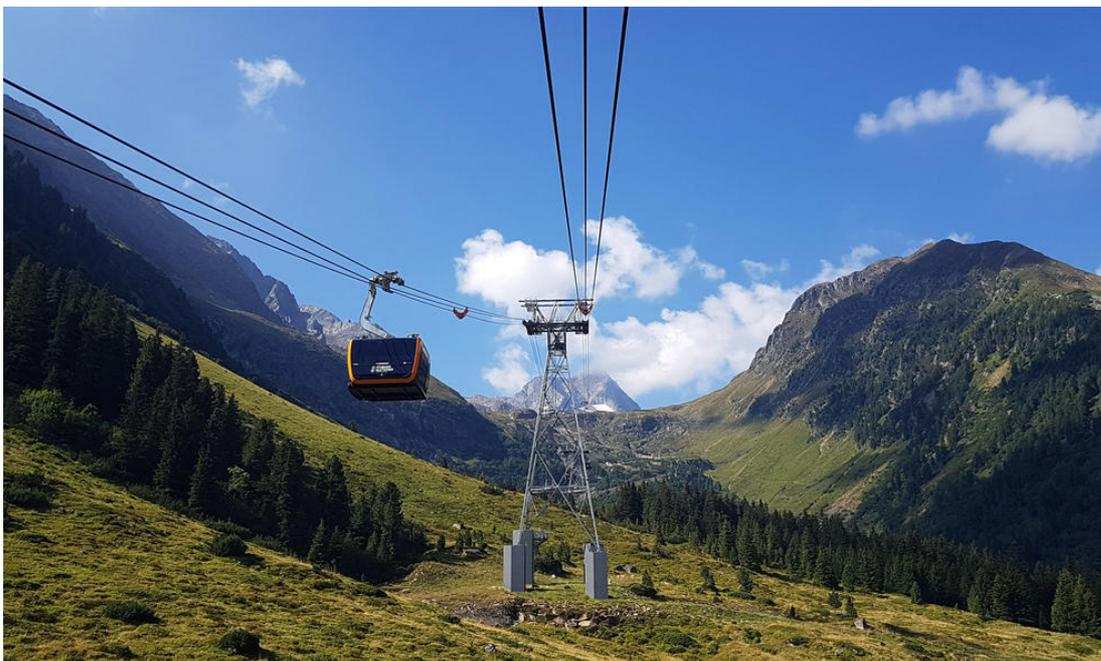
Bild: Flexible Strukturen, wie sie zum Beispiel bei Gondelbahnen zum Einsatz kommen, stehen im Zentrum des neuen Ausbildungsnetzwerks. Hier: Gondelbahn mit einem Zugseil und zwei Tragseilen. (Credit: Johannes Gerstmayr)
